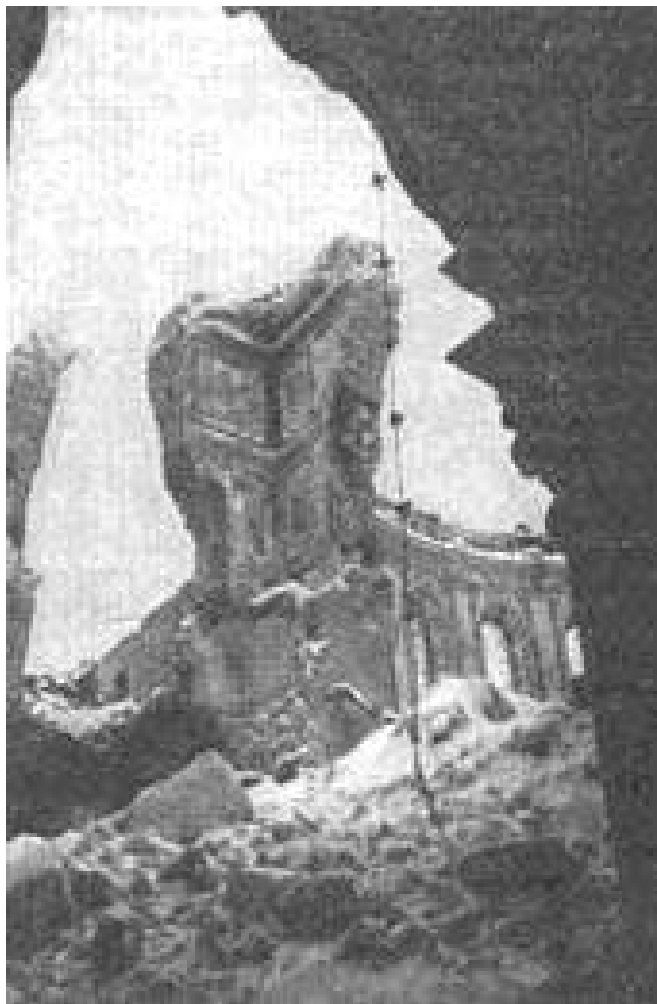
Ново-Иерусалимский монастырь, разрушенный гитлеровцами. Фотография.
